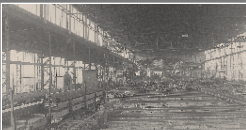
Blick in das Innere der Fabrikationshalle von Hermann Honnef, die an Stelle der Luftschiffhalle erbaut wurde.
