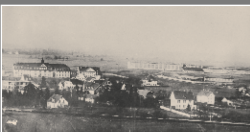
Blick auf die ehemalige Luftschiffkaserne sowie die Honnefwerke.
